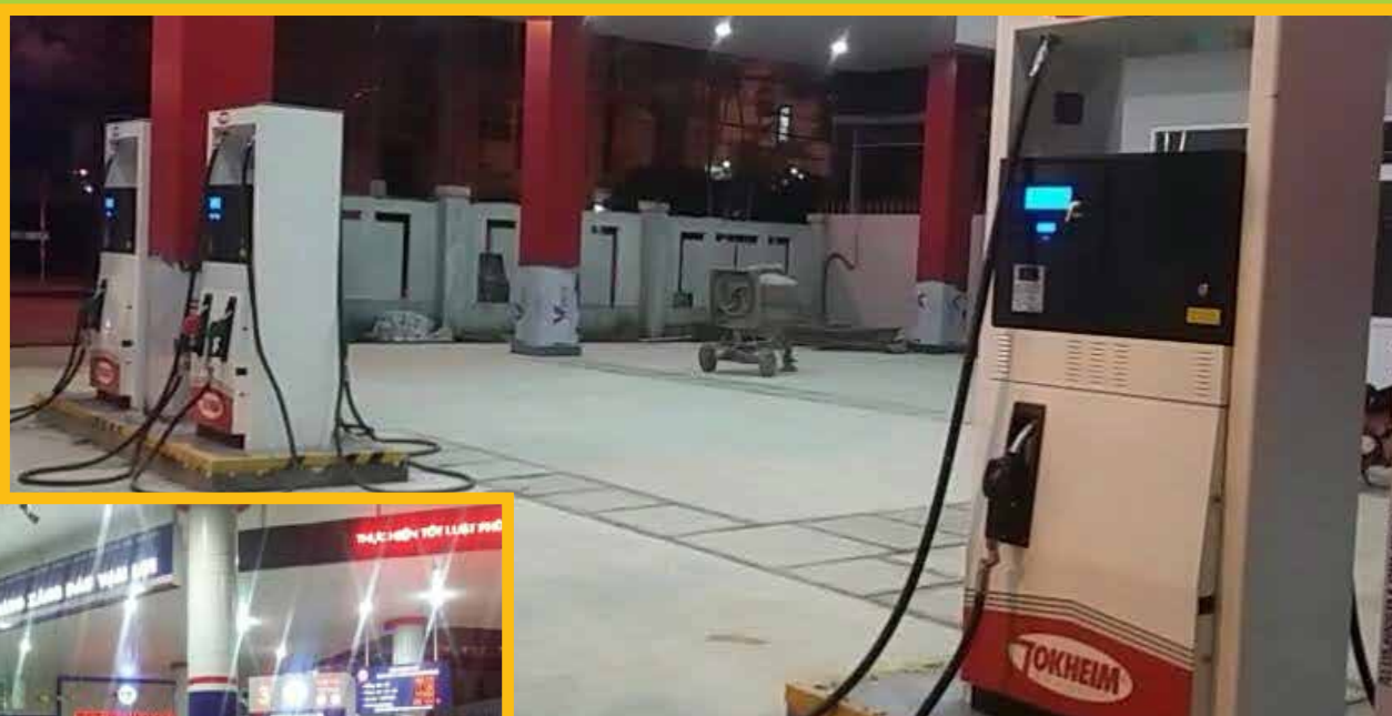
➤ Trạm xăng dầu Hoà Khánh
