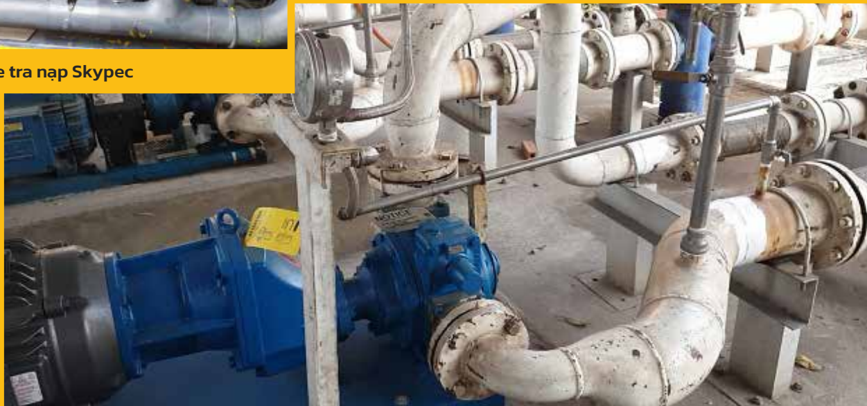
➤➤ Cải tạo trạm bơm Skypec
